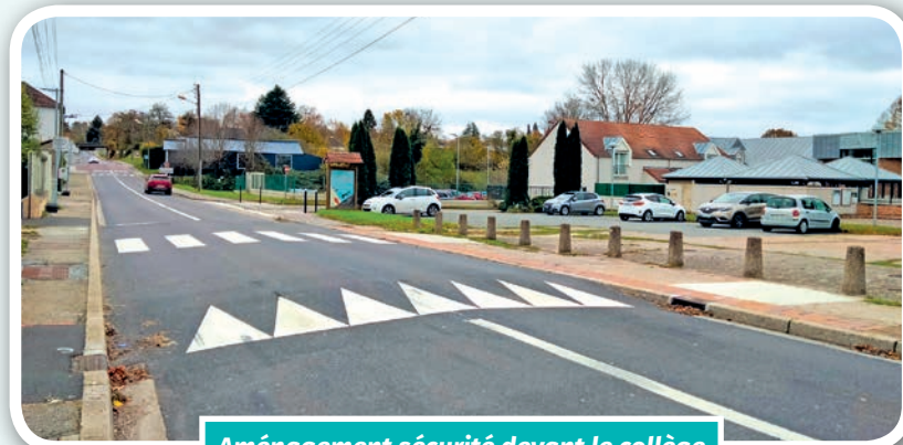
Aménagement sécurité devant le collège
